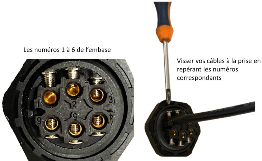
Figure 9 : Installation des 6 câbles sur l'embase
